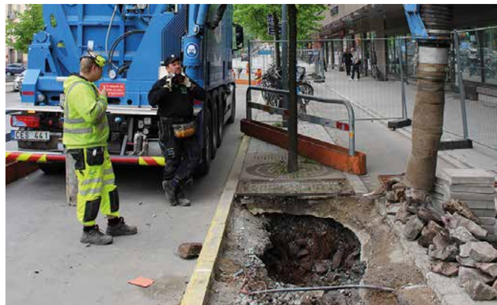
Provgrävning i skelettjord för utvärdering av rotutbredning.
