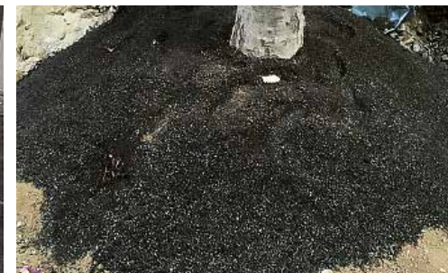
Årtäckning av rötter med kolmakadam.
