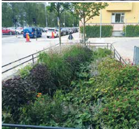
Perenner i växtbädd med kolmakadam vid plantering och efter två växtsäsonger – Pilgatan.
