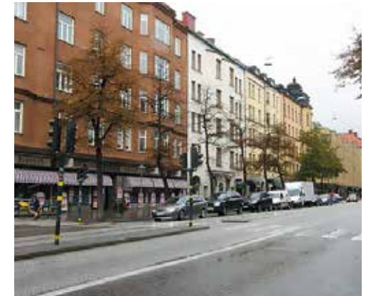
Stadsträd med dålig tillväxt – Odengatan.
