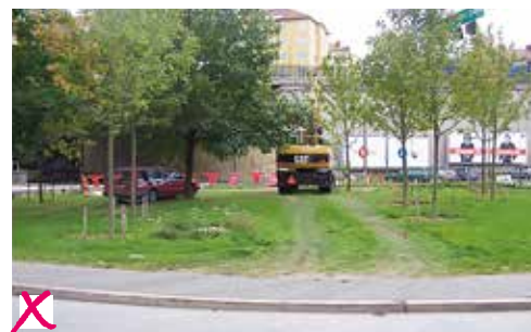
Ingen avspärning: uppställning av bil och fordon som vid upprepade tillfällen kört i rotzonen.
