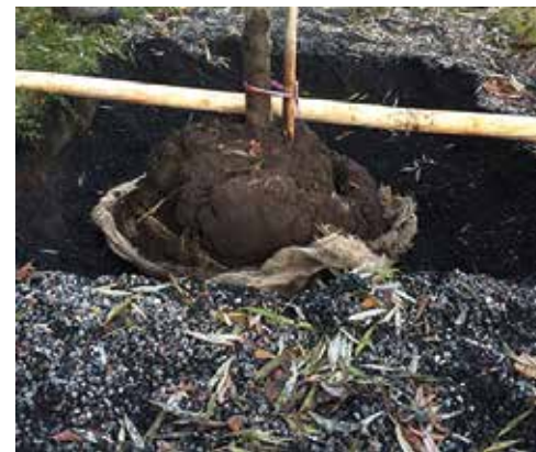
Trädets rothals placeras i samma nivå som i plantskolan. Höjdläget justeras vid behov med makadam i trädgropsens botten. Foto Lovisa Hell.
