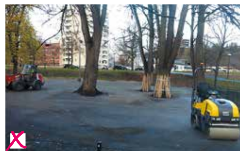
Ingen avspärning och inget skydd mot markkompaktering
