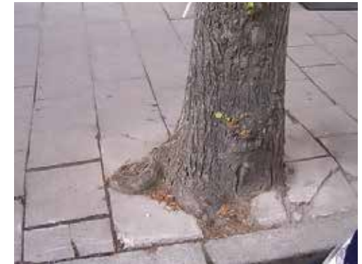
Beläggning som ansluter allt för tätt mot stam.
