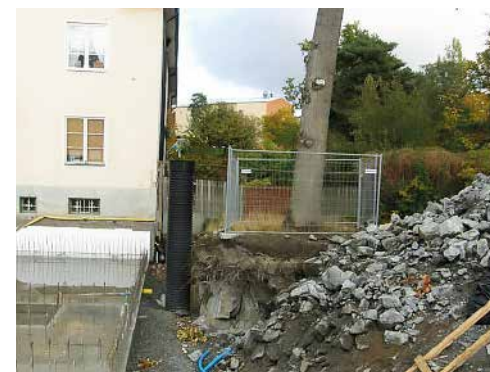
Alla träd är inte möjliga att spara vid nybyggnation. Detta träd har ingen chans att överleva.
