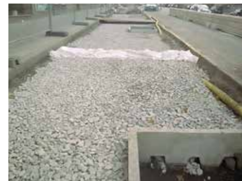
Dämmen av geotextil i luftigt bärlager.
